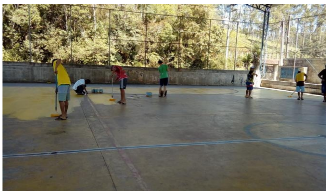
Início da reforma quadra poliesportiva
